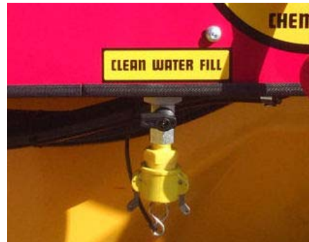
Collecteur du réservoir de lavage
