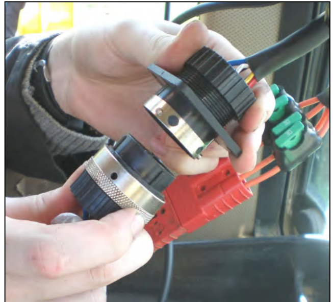
Spojite upravljačke vodove na upravljačku jedinicu stroja u kabini traktora.
