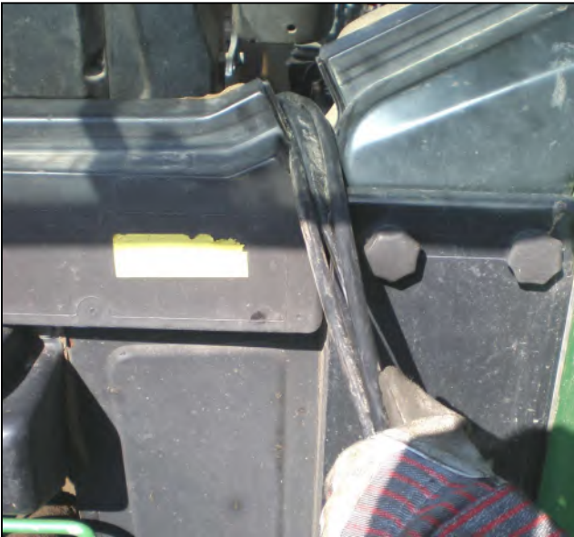
Ugradite upravljačke vodove u kabinu traktora – izbjegavajte oštre zavoje i držite vodove podalje od svih pokretnih dijelova na stroju ili traktoru.
